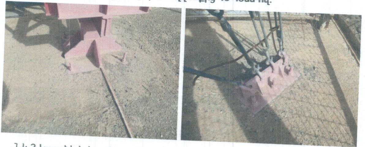
Նկ.3 Կայանի և ձգաճուպանների հիմքերի վերգետնյա հատվածամասերի տեսքեր
